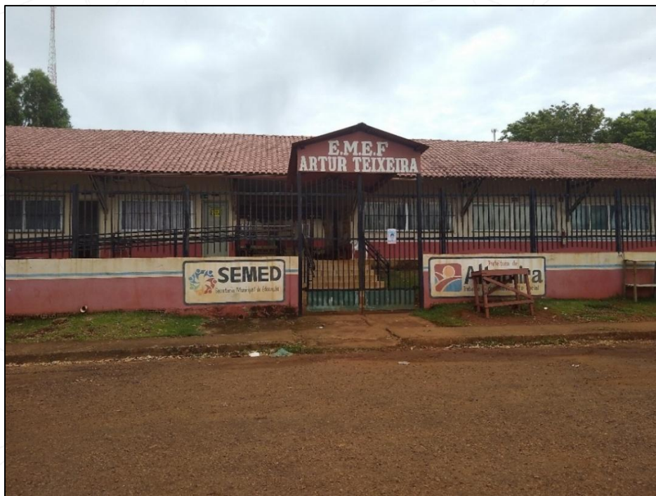
Figura 2 – Vista frontal da escola
